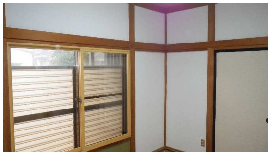
内窓の取付け
