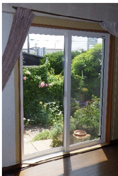
断熱サッシに交換
