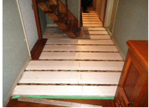
廊下の床を修繕する時にも、しっかりと断熱。
