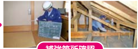
補強箇所確認
